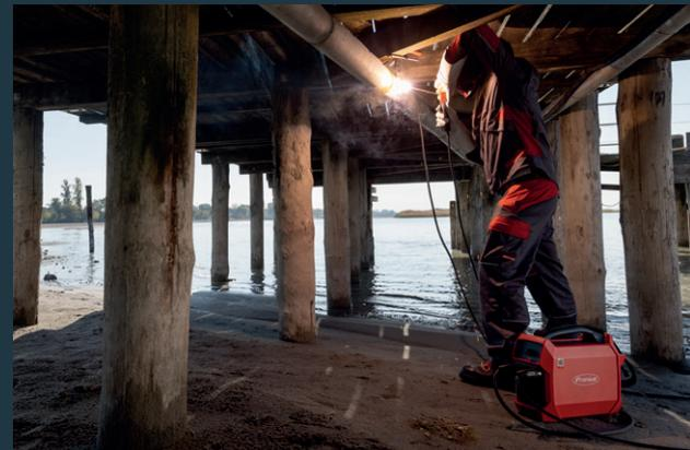
Mit nur einer Akkuladung können bis zu 27 Stück 2,5 mm Elektroden verschweißt werden.
